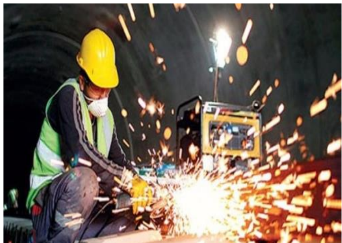
Gambar 5. Tenaga ahli sangat diperlukan dalam pembangunan
